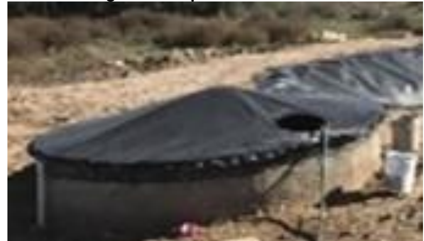
Figura 4 Tanque de lixiviados.
