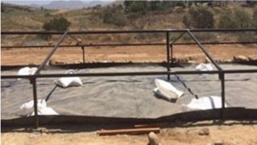
Figura 3 Construcción del sistema de lombri-compostaje.
