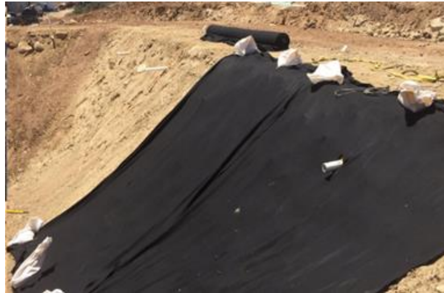
Figura 2 Construcción del digester.
